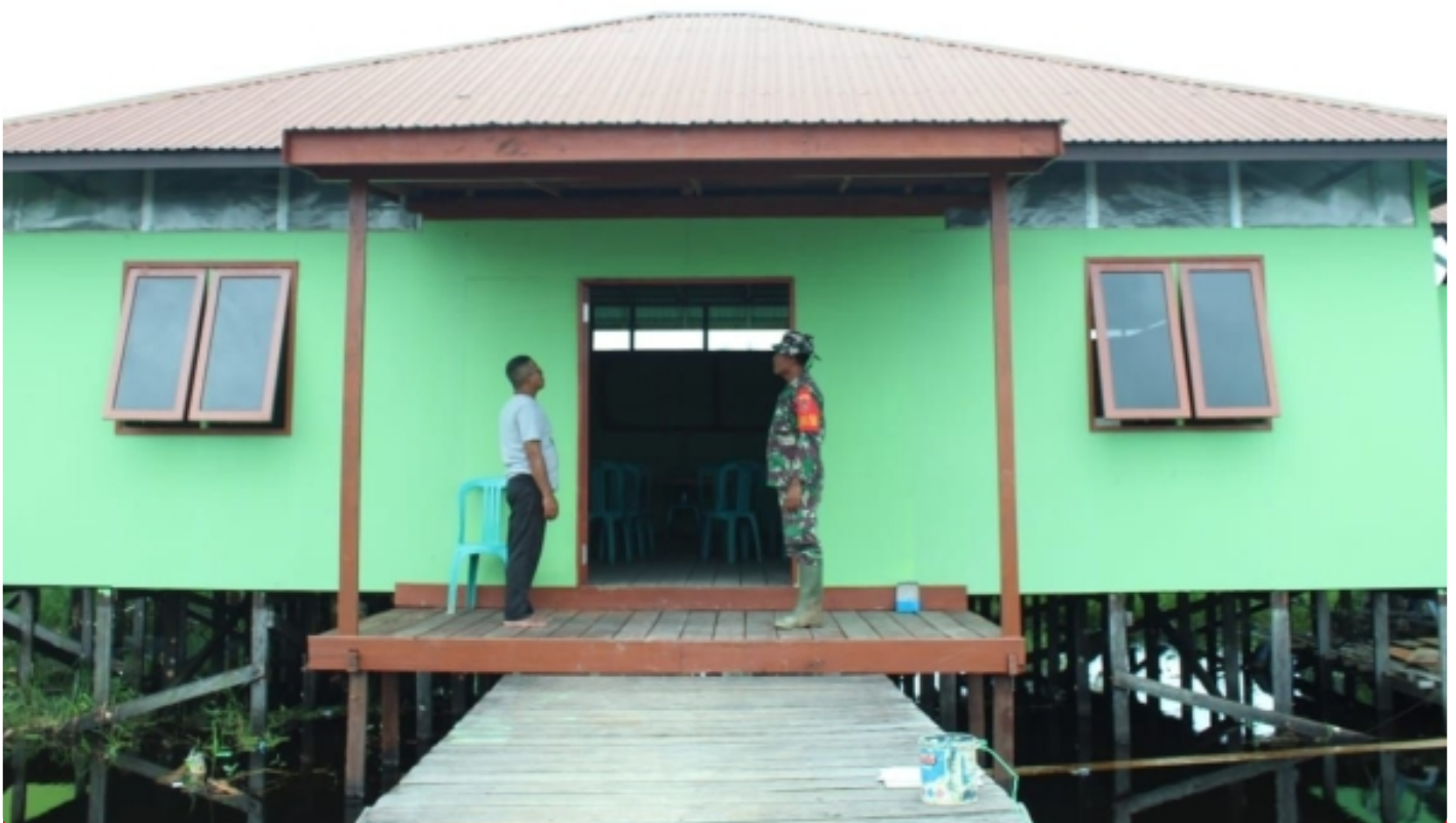
Rehab Balai BPD Rampung 100 Persen
