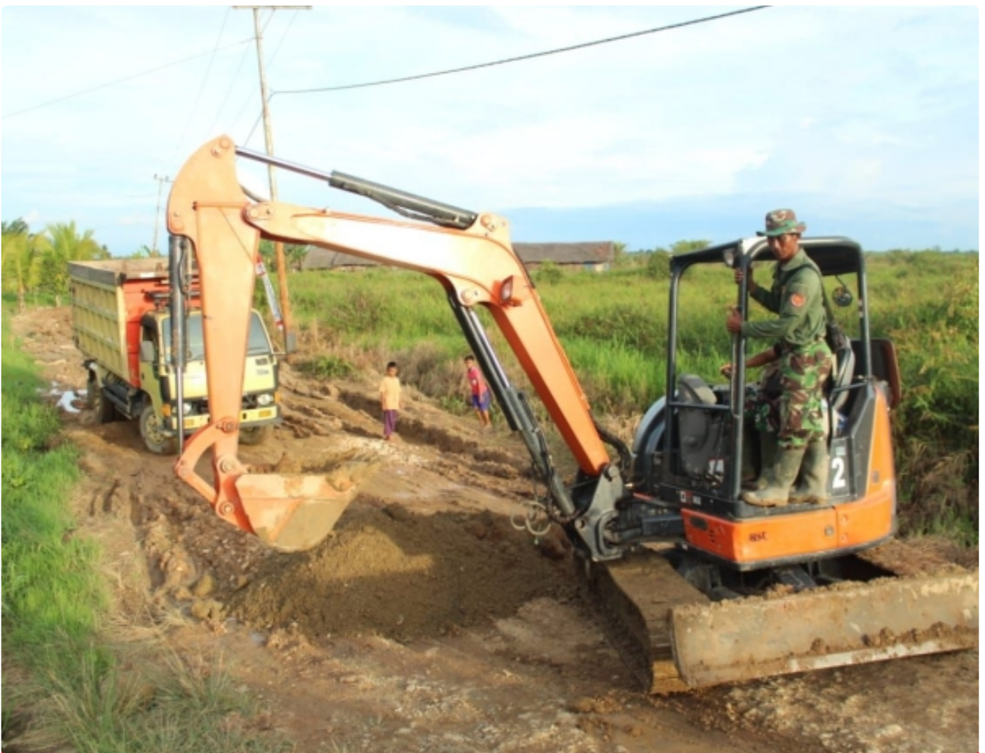
Satgas TMMD ke-115 Kodim 1001/Hsu-Blg Kerahkan Excavator
