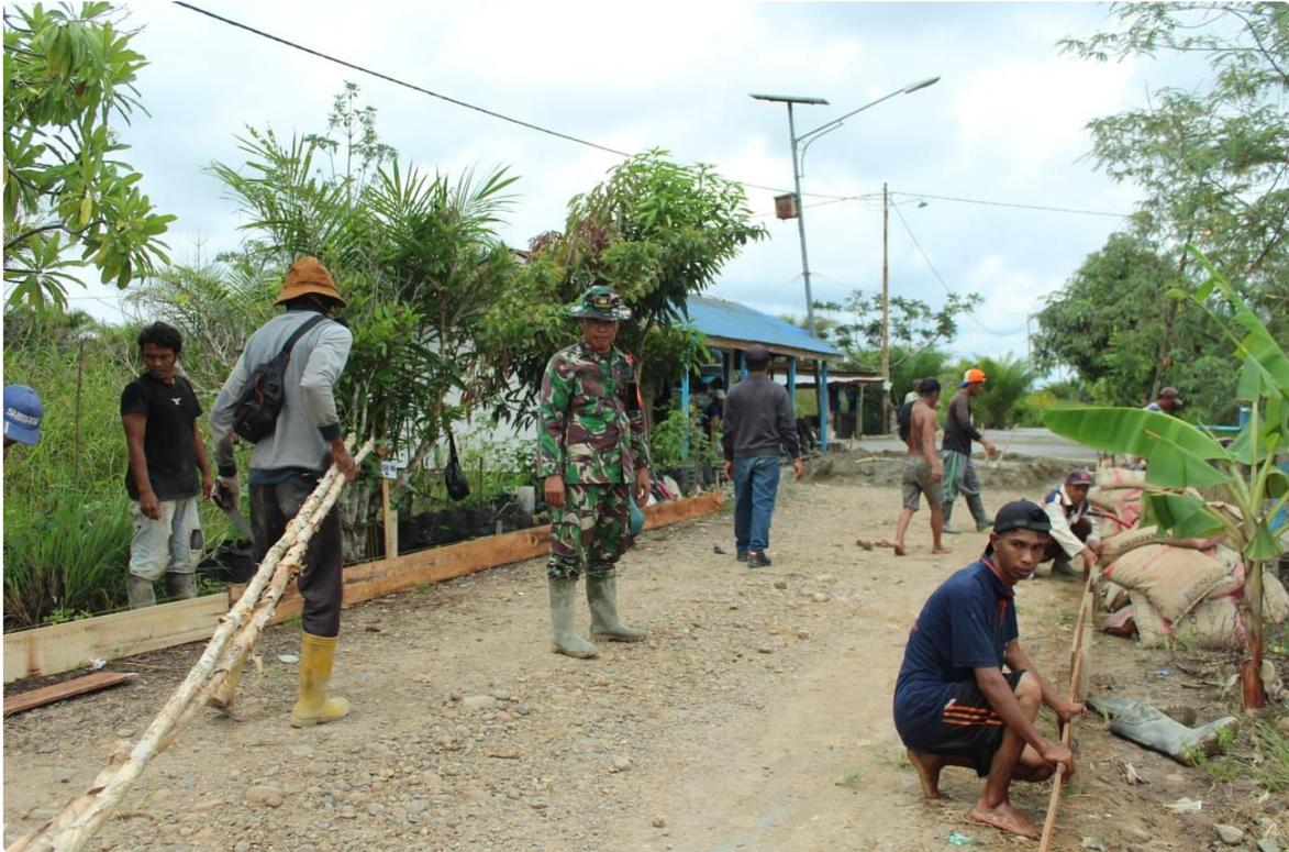
Papan bekisting merupakan cetakan yang dibuat pada pengecoran jalan supaya diperoleh bentuk yang di inginkan, papan bekisting terus di pasang di sisi kiri dan kanan jalan.
