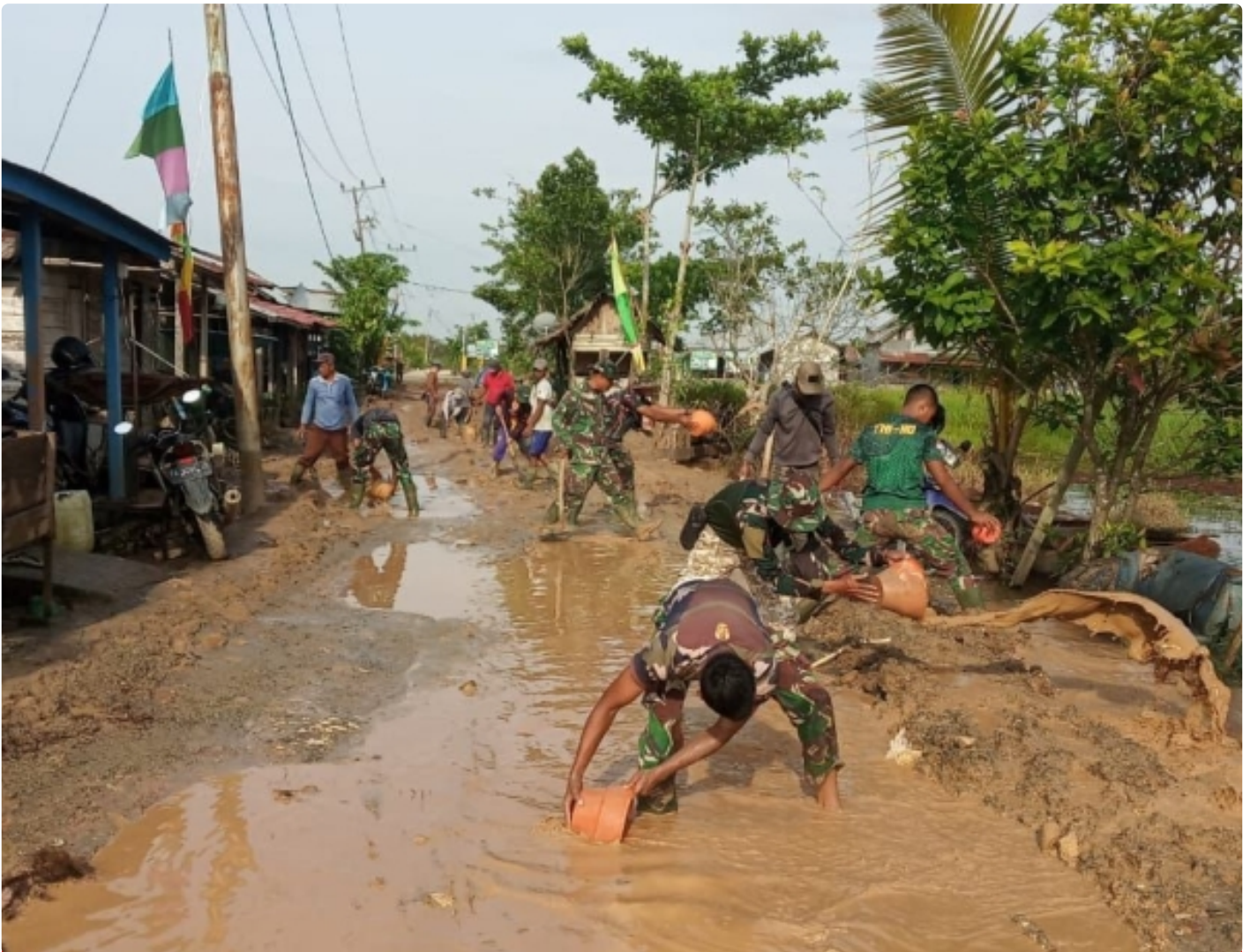
Personel Satgas TMMD Kuras Kubangan Lumpur Demi Percepatan Pengecoran Jalan
